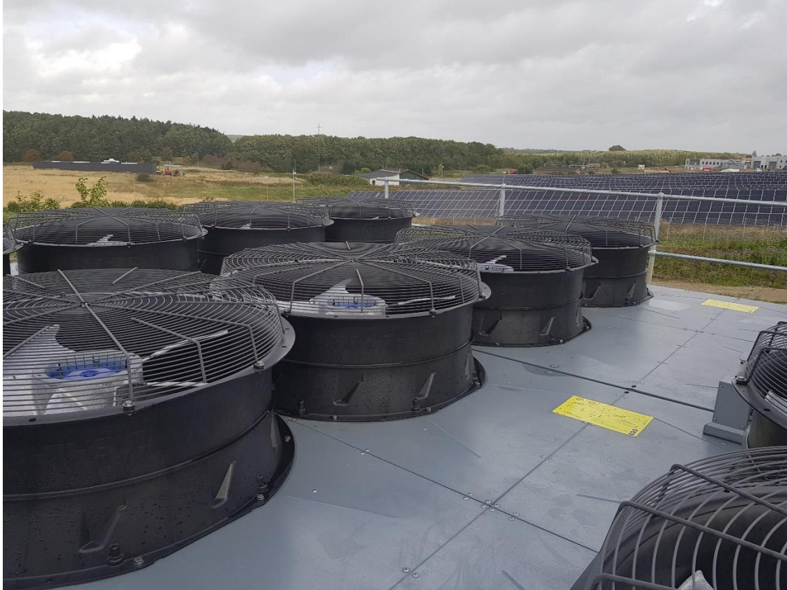
Foto: Assens Fjernvarme: Luchtwarmtepompen en zonnepanelen als lokale bron
